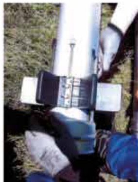
Centreur à segments munis d'un porte-sonde. PP usiné, assemblage par chevilles
